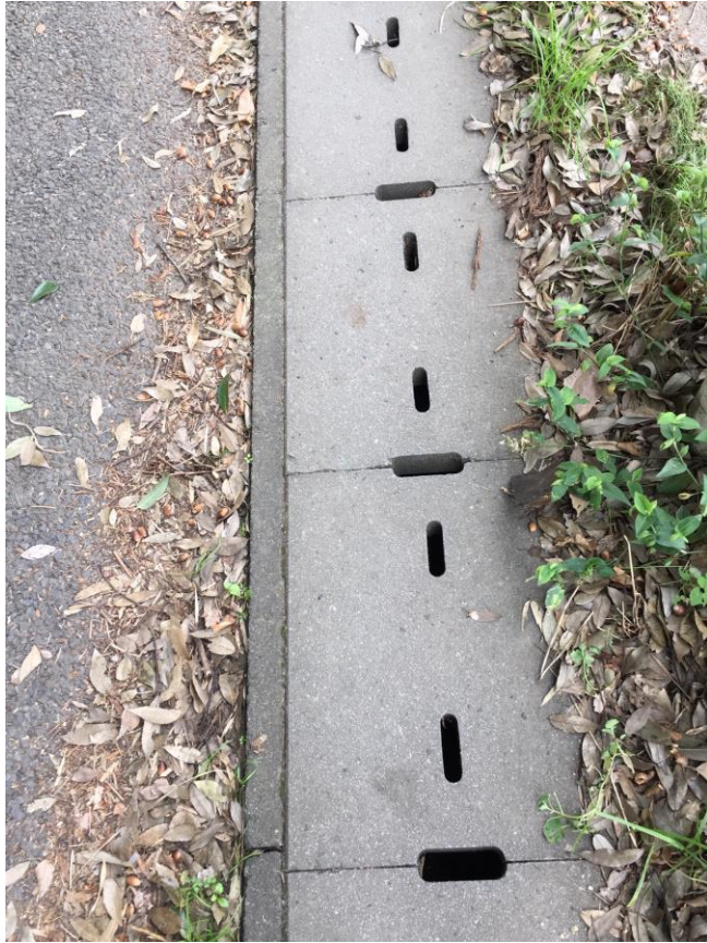
松戸市の舗道のグレーチング
